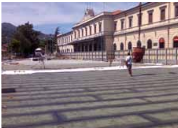
Impermeabilizzazione Stazione di La Spezia
