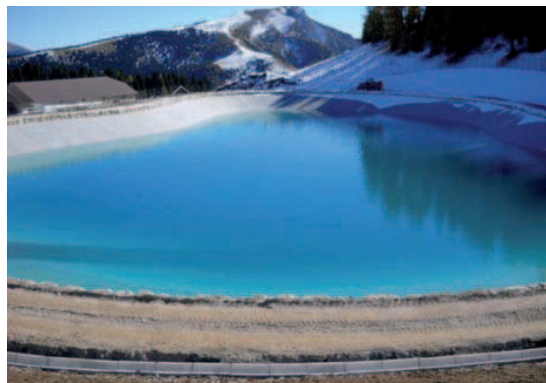
Passo Brocon (TN). Realizzazione di bacino per innnevamento artificiale con membrana sintetica e protezione dei bordi fuori acqua.
