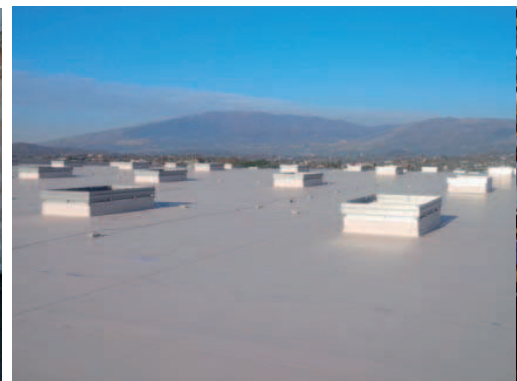
Magazzino logistica, Anagni (FR). Copertura con membrana sintetica fissata meccanicamente su solaio in lamiera.
