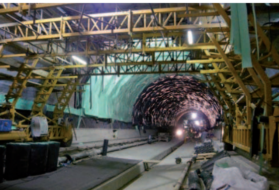
Monte Olimpino (CO). Impermeabilizzazione galleria parzialmente sottofalda con membrane sintetiche compartimentale per la verifica di tenuta.
